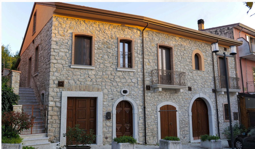
RIVESTIMENTO PORTONI IN BRECCIA IRPINA BOCCIARDATA
