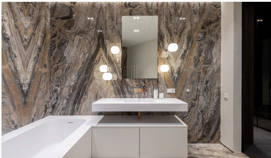
RIVESTIMENTO BAGNO IN MARMO A MACCHIA APERTA
